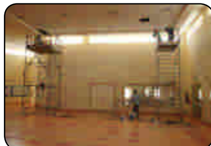
作業のようすと取り付けられた「天井ボード落下防止ネット」
